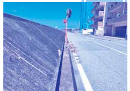
③ 護岸堤防の町道側の側溝に蓋がないため車両等脱輪の危険がある。
