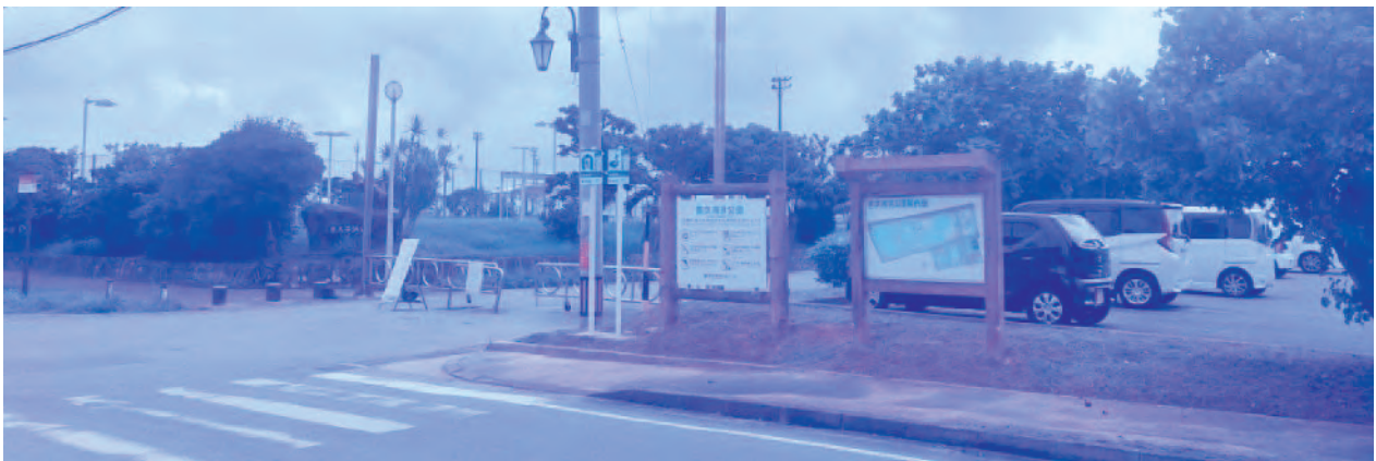
リニューアル工事が進捗中の兼久海浜公園
