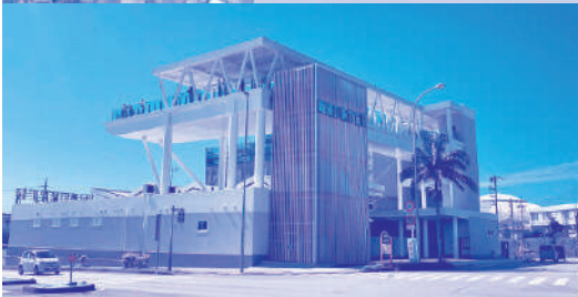
空き店舗が懸念される道の駅かでな
