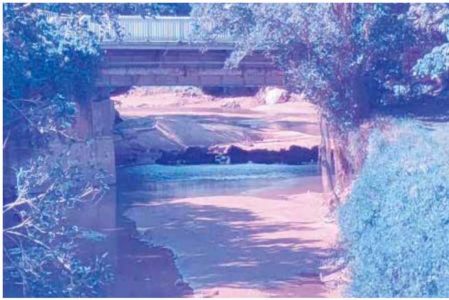
比謝橋（上）川満潮時の水位 橋の前方奥に堰撤去現場
