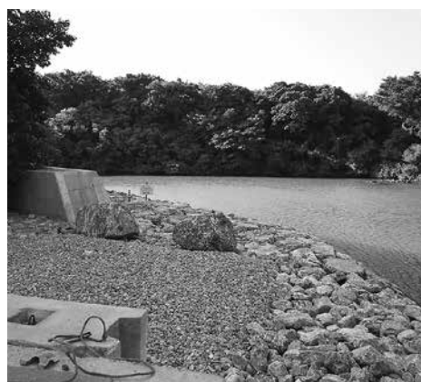
土砂流出対策が施された嘉手納漁港北側護岸
