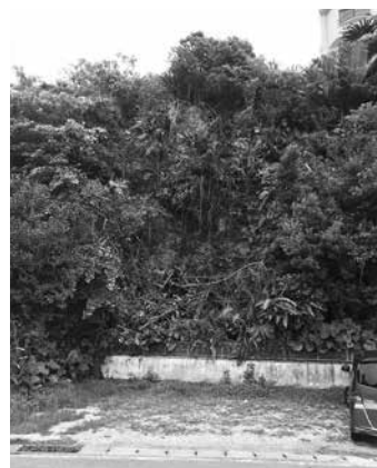
町内での土砂災害の状況
