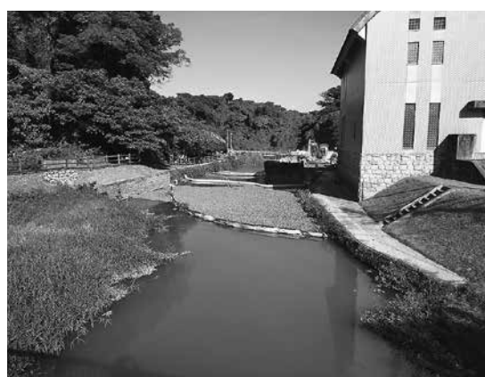
新取水堰建設中の長田川
