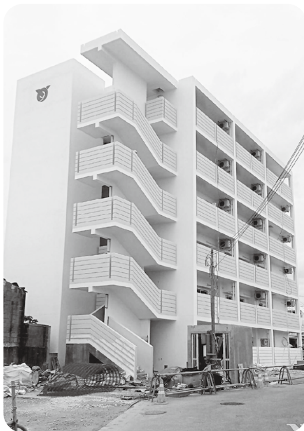
整備が進む都市再生住宅
