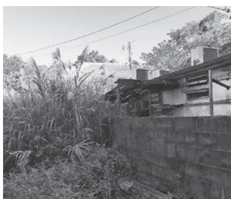
人のなくなった空き家は、老朽化が進み最悪の場合倒壊の恐れがある。
