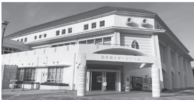
スポーツドーム照明取替工事（工事期間 8月～12月予定）
