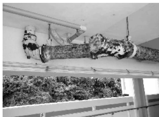
塩害による腐食が激しい水釜高層住宅の配管
