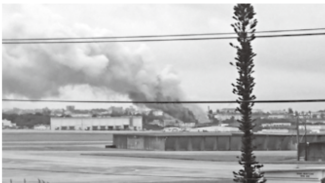
激しく炎上する危険物取扱施設
