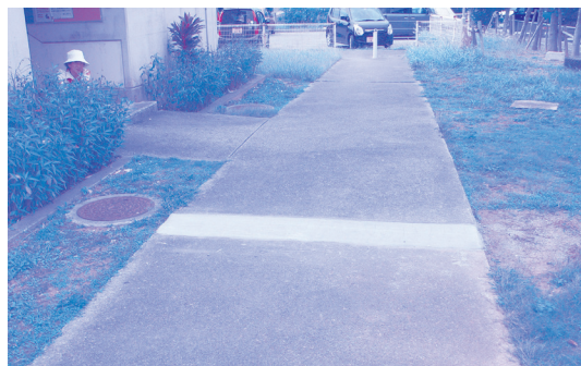
段差が解消された団地内の歩道
