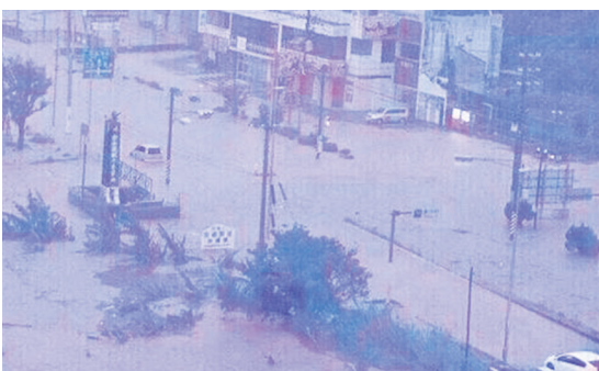
比謝川が冠水し通行不能となった国道 58 号
