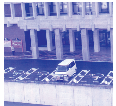
庁舎車いす利用者用駐車場上屋設置工事
