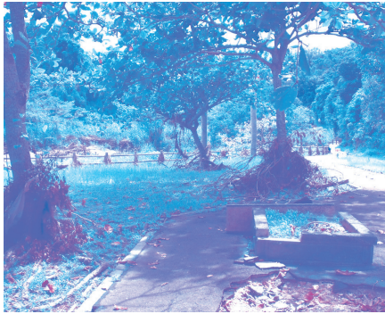
屋良城跡公園等復旧工事
