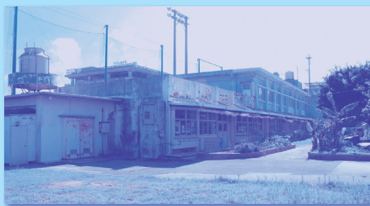
嘉手納幼稚園仮設園舎賃借料 嘉手納幼稚園仮設園舎敷地整備工事 3,779 万円
