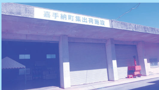
集出荷施設電動シャッター取替工事 329 万円
