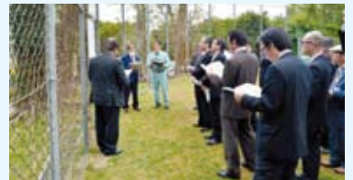
屋良団地建設現場視察
